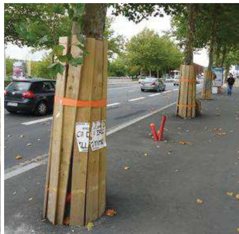
Exemple d'ajout de planches de bois autour de la gaine (source : www.lebloguejardin.com )
