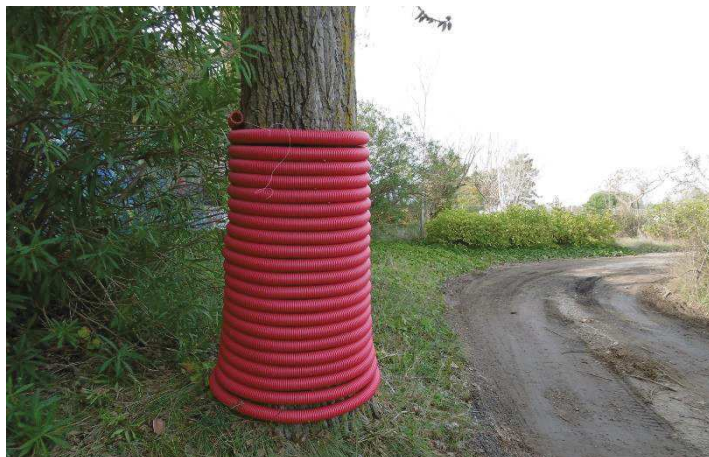
Exemple de protection par mise en place d'une gaine flexible – CBE, 2018
